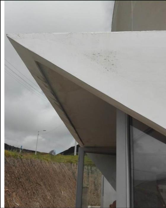
Foto 9. Humedad en la cubierta
