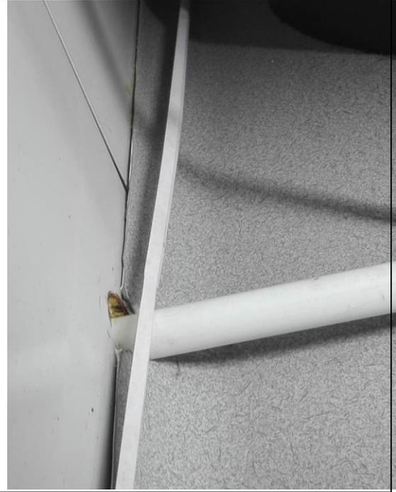
Foto 32. Perforación lateral con deficientes acabados.
