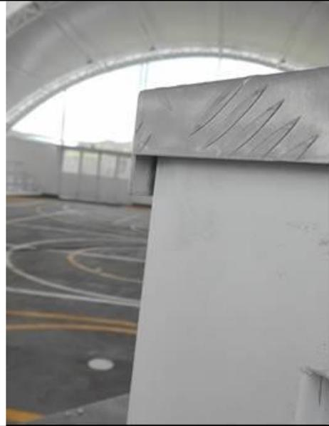
Foto 26. Defectos en el terminado de las estructuras de las graderías que presenta peligro a la comunidad.
