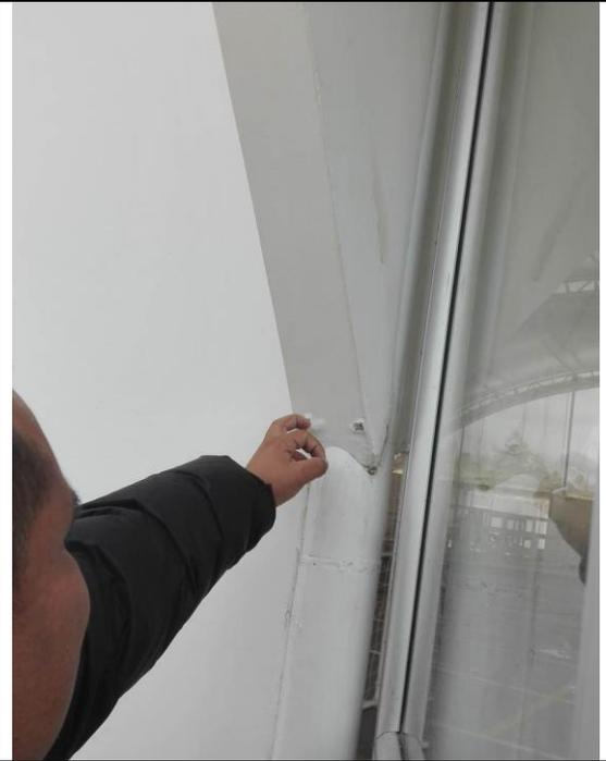
Foto 10. Humedad y desprendimiento de la pintura
