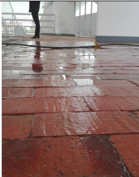
Foto 23. Deficiencia de nivelación del terreno.
