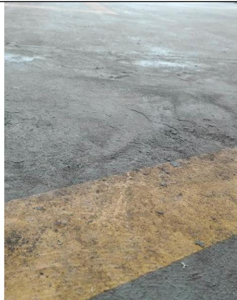
Foto 24. Presenta desprendimiento de la estructura de piso de la cancha multipropósito.
