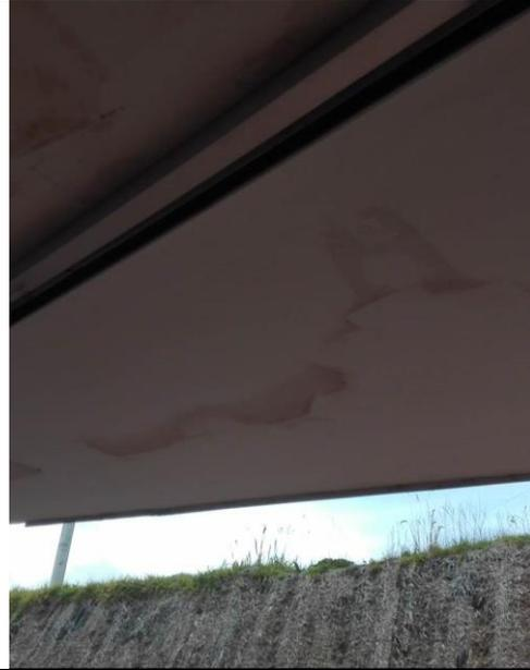
Foto 22. Humedad y desprendimiento de la pintura.
