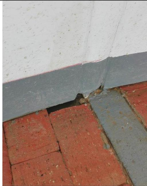
Foto 16. Separación de adoquín.
