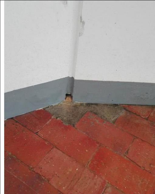
Foto 19. Falta de adoquín y deficiente terminado.
