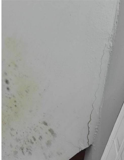
Foto 7. Fisura longitudinal.
