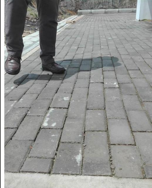
Foto 5. Separación de adoquines.
