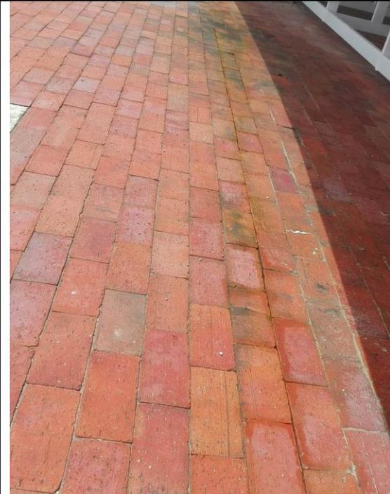
Foto 3. Huella en el adoquín de caída de agua de la cubierta.
