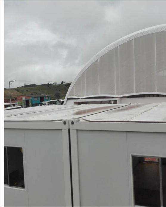
Foto 31. Apozamiento en el techo de las estructuras.
