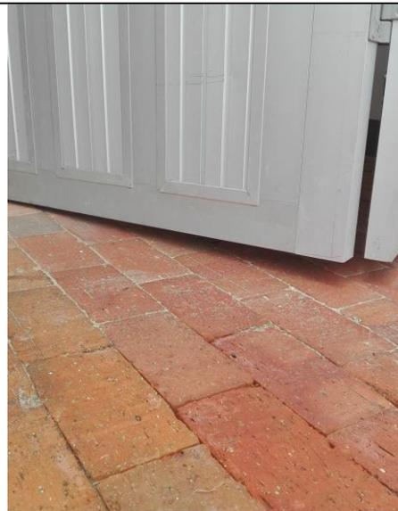
Foto 28. Desnivel del adoquín de la
